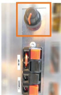
Le potentiomètre situé sur le caisson du booster régulé intégré permet d'adapter le débit d'air maximal fourni par le booster. Pour information, le débit maximal réglementaire par bouche est de 60 m<sup>3</sup>/h.
