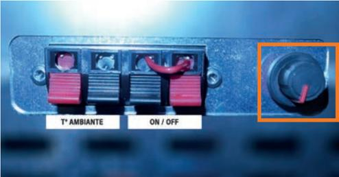
Le potentiomètre situé sur le caisson du booster déporté permet d'adapter le débit d'air maximal fourni par le booster. Pour information, le débit maximal réglementaire par bouche est de 60 m<sup>3</sup>/h.
