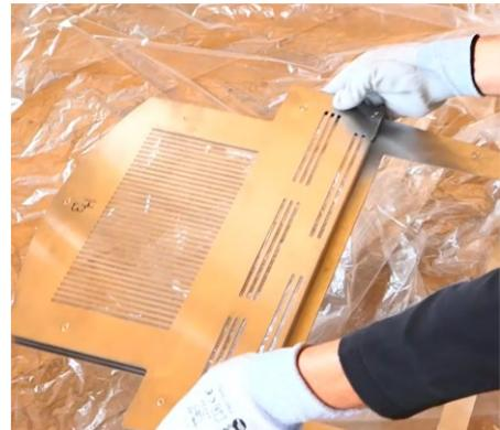
3.4 Après démontage des habillages, débrancher le tube PVI avant toute autre opération pour éviter d'endommager ce capteur sensible :
